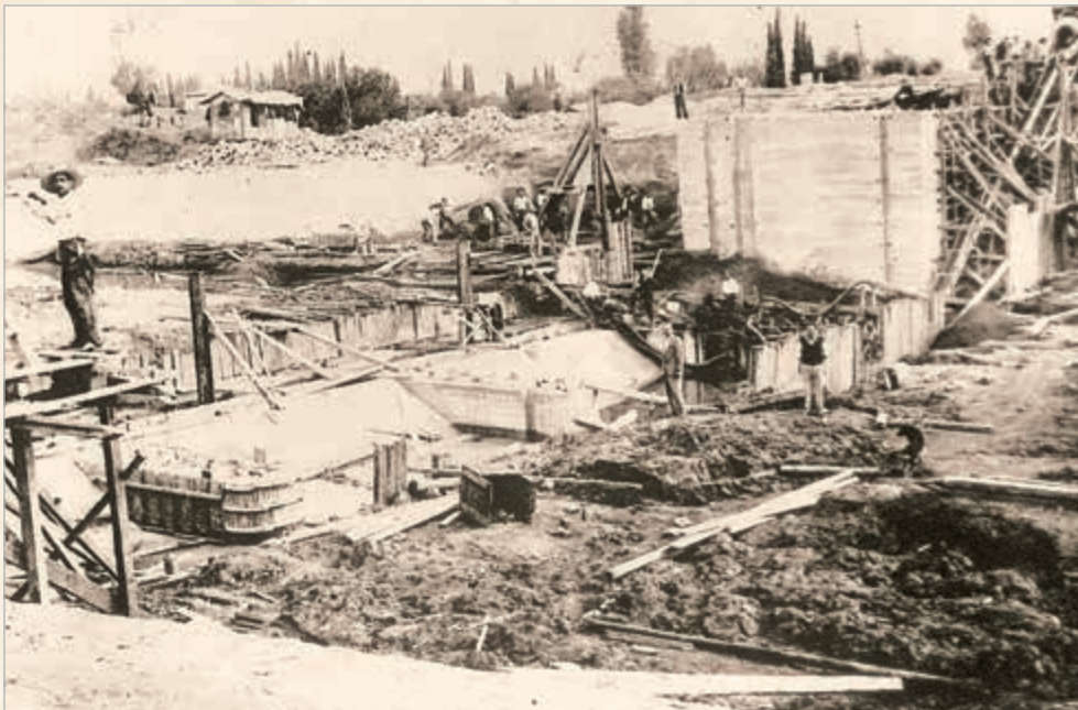
Κατασκευή μόνιμου αρδευτικού φράγματος επί του Παμίσου ποταμού (πηγή: Ιστορικό Αρχείο ΠΙΟΠ/ Ειδική Βιβλιοθήκη, ΑΤΕ, Το έργο μιας δεκαετίας 1930-1939, 1940)
