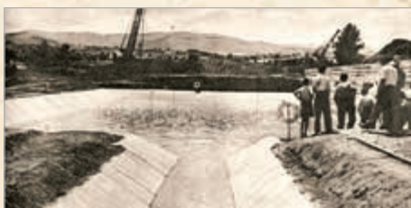
Η αρχή της ανοικτής τάφρου από μπετόν, μήκους 5.500 μ. του υδραγωγείου του Αγίου Θωμά, με χρήματα της Αμερικανικής Βοήθειας (πηγή: Ιστορικό Αρχείο ΠΙΟΠ/Ειδική Βιβλιοθήκη, Το Σχέδιο Μάρσαλ στην Ελλάδα: ο πλήρης απολογισμός της βοήθειας του Σχεδίου Μάρσαλ προς την Ελλάδα, Ιούλιος 1948-Ιανουάριος 1952)
