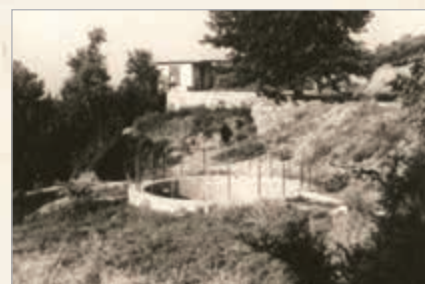
Αποχευτική διώρυγα στο αποξηραντικό έργο Ν. Αρτάκης (πηγή: Ιστορικό Αρχείο ΠΙΟΠ/Ειδική Βιβλιοθήκη, ΑΤΕ, Το έργο μιας δεκαετίας 1930-1939, 1940)
